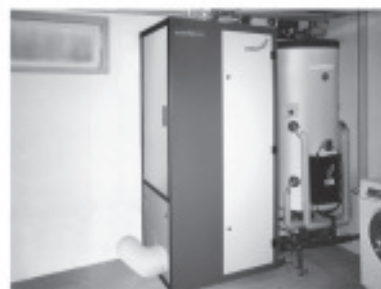
Betriebsbereite, wartungssame Kompakteinheit combox für das MINERGIE Einfamilienhaus mit Sole-/Wasser-Wärmepumpe mit Kühlfunktion
