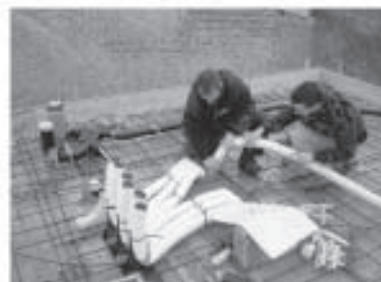
Einfach verlegbares, flexibles Lüftungssystem comlofresh mit wenigen Komponenten
