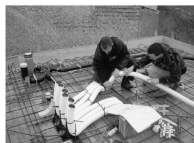
Einfach verlegbares, flexibles Lüftungssystem comfobresh mit wenigen Komponenten
