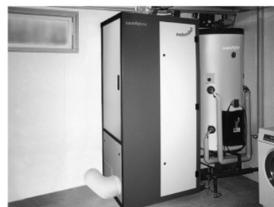
Betriebsbereite, wartungsarme Kompakteinheit combox für das MINERGIE Einfamilienhaus mit Sole-/Wasser-Wärmepumpe mit Kühlfunktion
