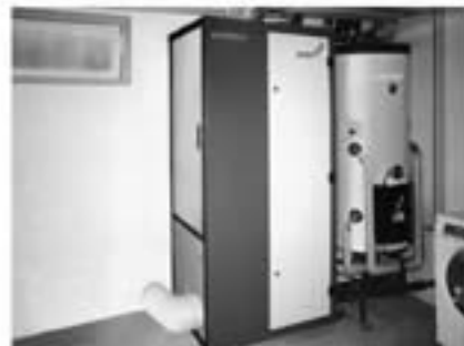
Betriebsbereite, wartungsarme Kompakteinheit comfobox für das MINERGIE Einfamilienhaus mit Sole-/Wasser-Wärmepumpe mit Kühlfunktion
