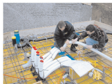
Einfach verlegbares, flexibles Lüftungssystem comfresh mit wenigen Komponenten
