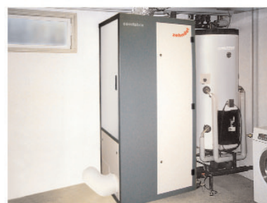
Betriebsbereite, wartungsarme Kompakteinheit comfoair für das MINERGIE Einfamilienhaus mit Sole-/Wasser-Wärmepumpe mit Kühlfunktion
